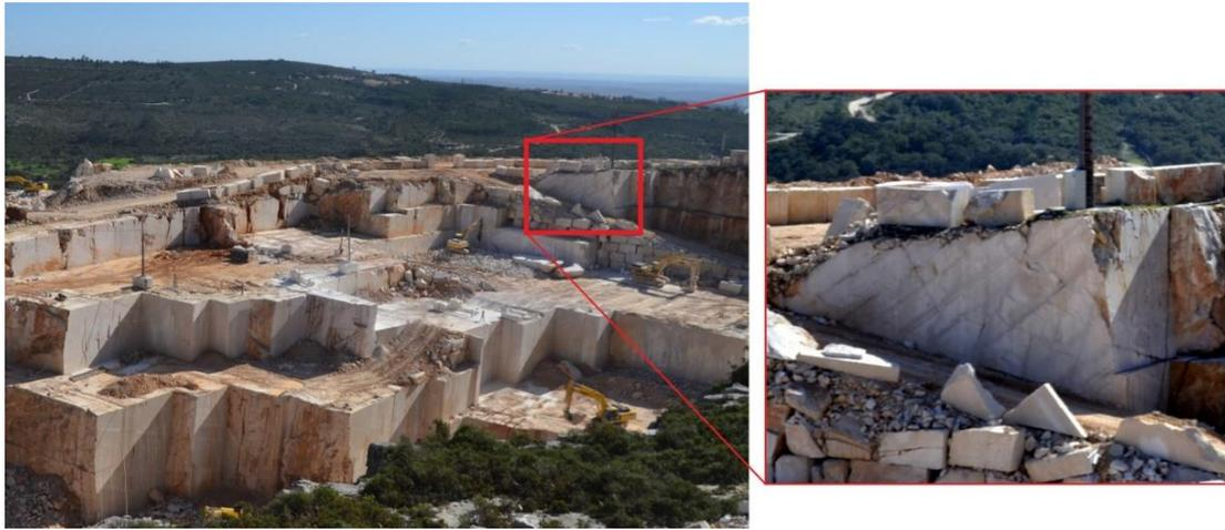
Figura 49. Vista parcial para sul do núcleo de Cabeça Veada: frentes de exploração verticais, realçando-se o forte pendor para leste por parte dos Calcários Ornamentais.
