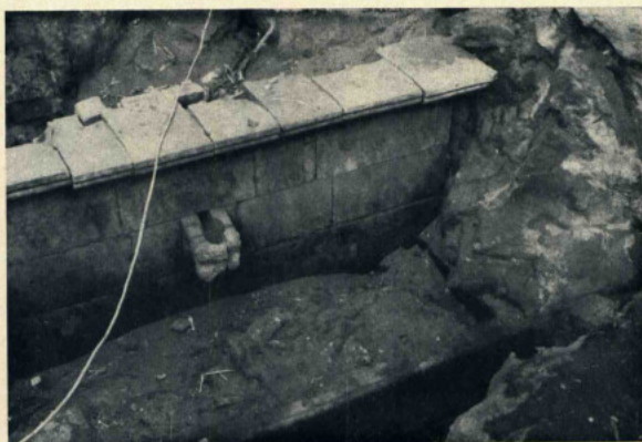
Fig. 1 — Vista do Fontenário durante o desaterro
