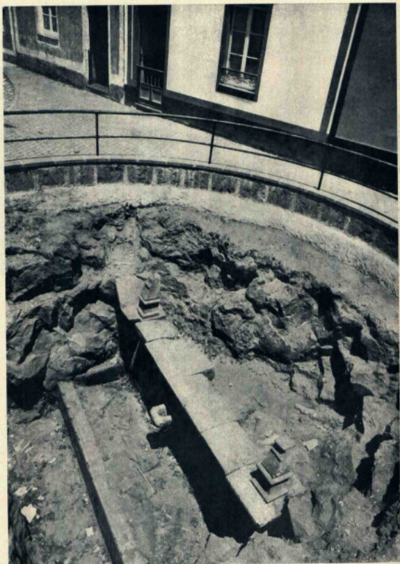
Fig. 1 — O Fontenário depois das obras de restauro e limpeza
