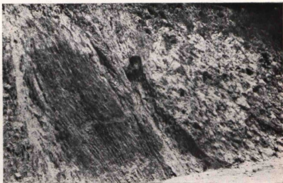
Fig. 2 — Falha entre o xisto (à esquerda) e o depósito de calhaus mal rolados (à direita). À saída de S. Teotónio, no ramal para a Zambujeira.
